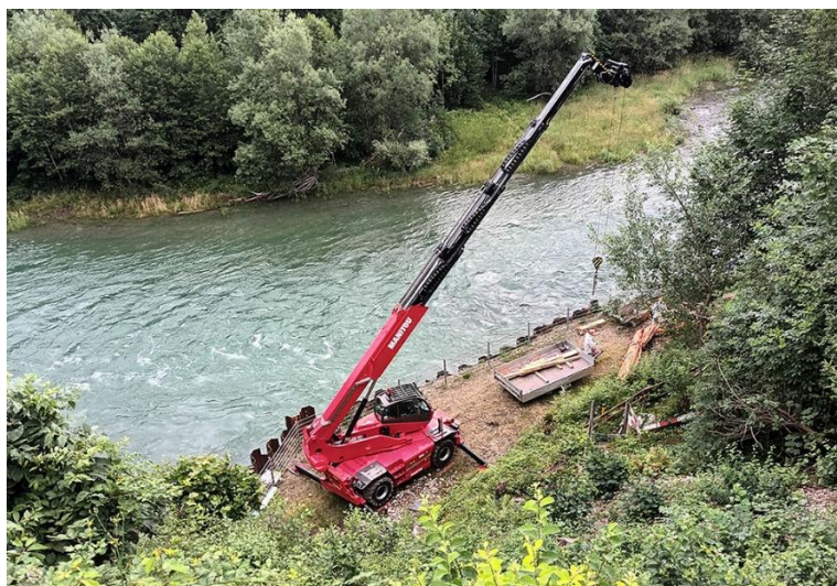
Ancienne décharge de la Pila, sécurisation du talus (photo CSD, juin 2022)
